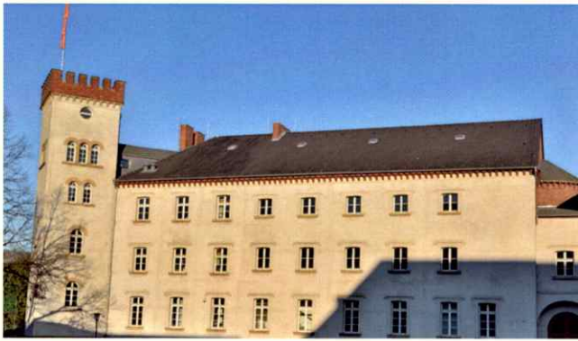
Der markanteste Überrest aus der Zuchthauszeit ist dieser Gebäudeflügel mit dem zinnenbewehrten Turm. Auf zwei Etagen war hier die Gefängniskirche eingerichtet.
